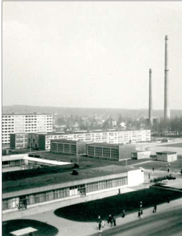
Um 1975 geht der Blick über das neue „Versorgungszentrum Hans Beimler“ zu den Schornsteinen des Ölheizwerks. In der Bildmitte ist der lange Block der beiden Oberschulen „Wilhelm Pieck“ und „Hans Beimler“ zu sehen. Davor stehen ihre zwei Turnhallen.
