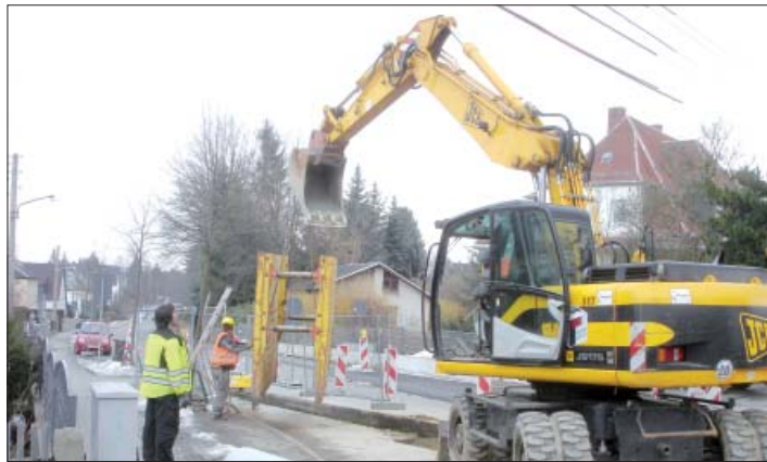
Bauarbeiten im Bereich Georgi- und Kleinolbersdorfer Straße.
