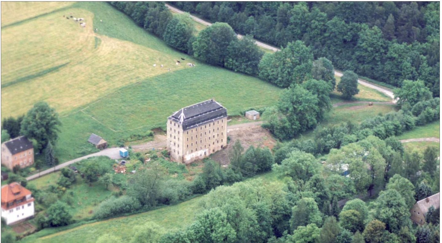
Luftbild der Merkel-Fabrik in Altenhain nach dem Abriss der Anbauten und Nebengebäude 2001. Das Foto wurde freundlicherweise von Herrn Gerald Leonhardt zur Verfügung gestellt.
