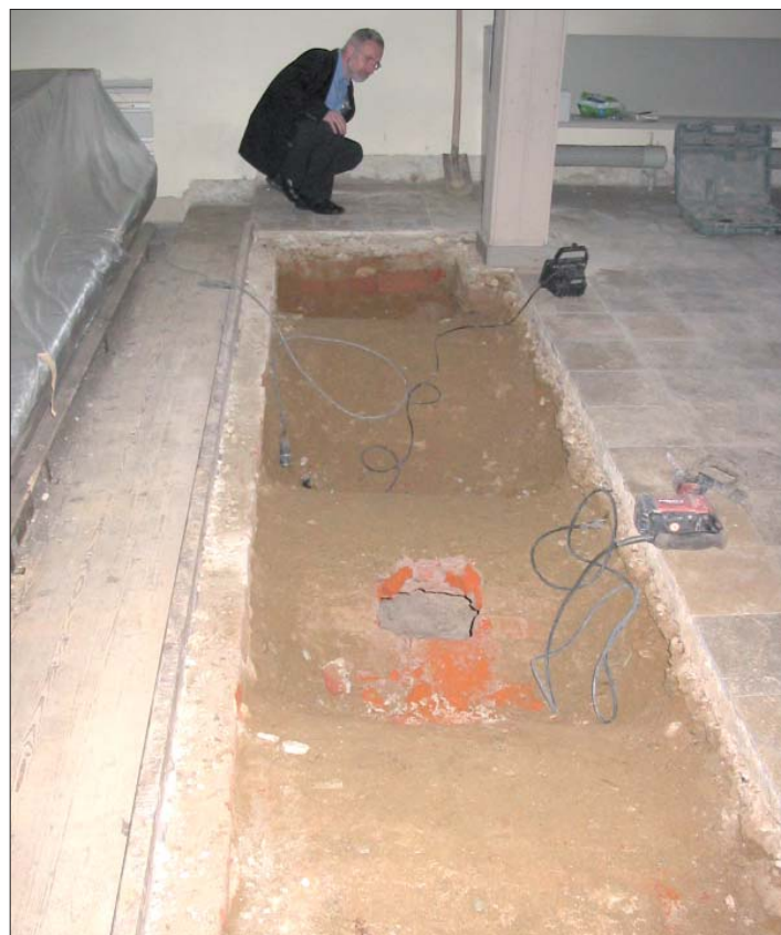
Erneute Öffnung der Grüfte bei den Bauarbeiten im Jahre 2004. Foto: Ingenieurbüro Niehsen-Baumann, Chemnitz.
