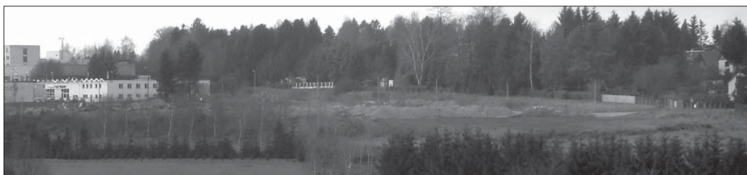
Blick von Osten auf das Baugelände im Herbst 2008.
